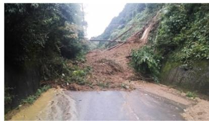
台風21号被害 県道多武峰見瀬線法面崩壊
